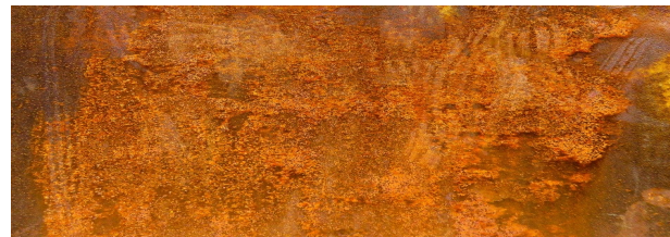
Nahaufnahme einer korrodierten Oberfläche
